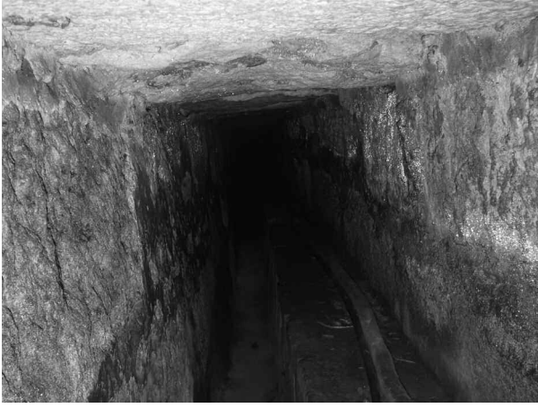
Klima sistemi, havalandırma kanalları
